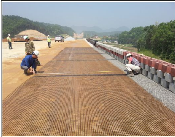
STA.4+750~4+978 그리드 길이 측정(서울방향)
