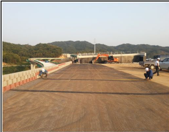
STA.4+750~4+978 옹벽 그리드 길이 측정(서울방향)
