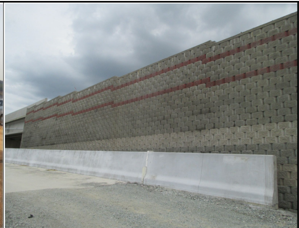
STA.4+750~4+978 옹벽 시공 전경(서울방향)
