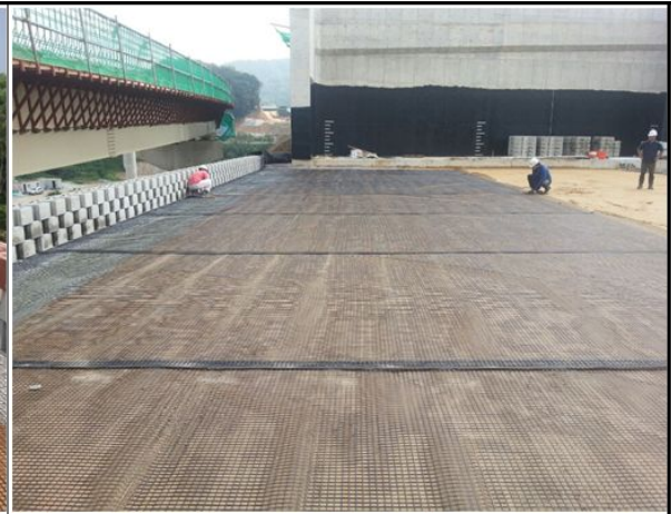
STA.4+750~4+978 그리드 길이 측정(서울방향)
